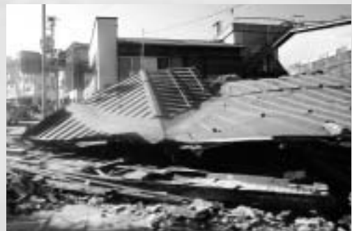
中越地震「小千谷市内の完全に倒壊した木造住宅」 (写真提供:川口助教授)
